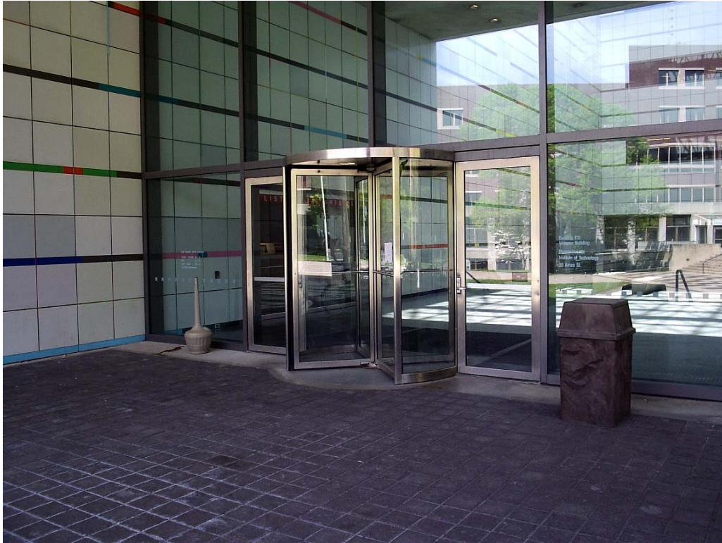
Figure A2. E15 (1) - Door facing E23.
